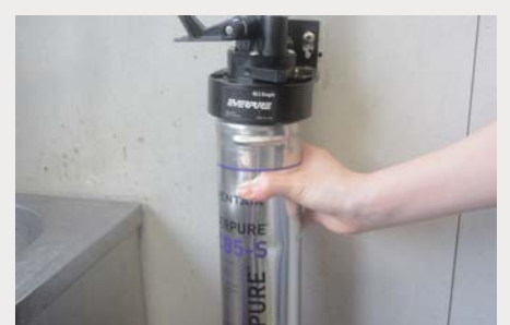
⑨ ヘッドを押さえながらカートリッジの凸部分をヘッド文字下あたりに合わせます。
