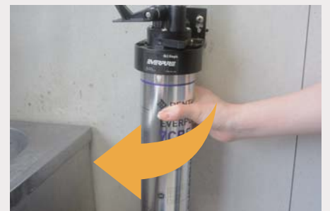
⑥ カートリッジを左方向に、止まるまで(約90度)回します。
